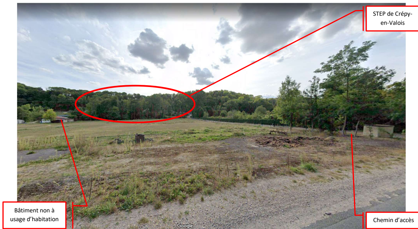
Figure 72 : Vue in-situ depuis RD116 – Google Street View
